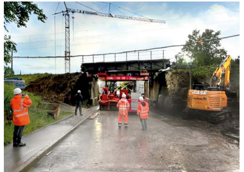
Ergenzingen: Die alte Brücke wurde abgebrochen und ausgebaut.
