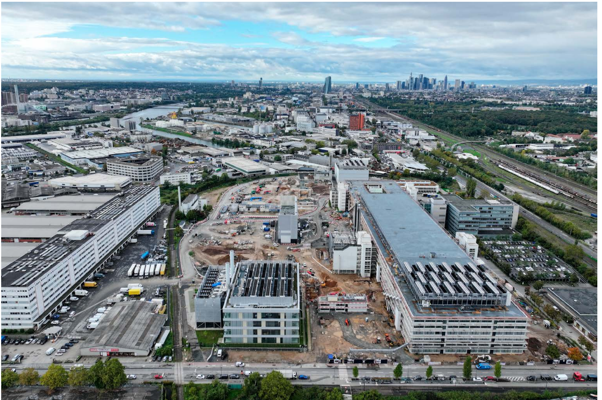
Aus der Vogelperspektive betrachtet lassen sich die bereits abgeschlossenen Leistungen im Digitalpark Fechenheim nur erahnen. Könnte man unter die Erdoberfläche schauen, gäbe es von Regenrückhalte- oder Löschbecken bis hin zu Trassen aller Art viel zu sehen.
