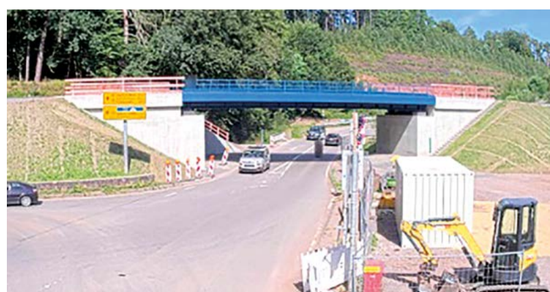
Hochspeyer: Die Stahlbrücke III ist bereits freigegeben.
