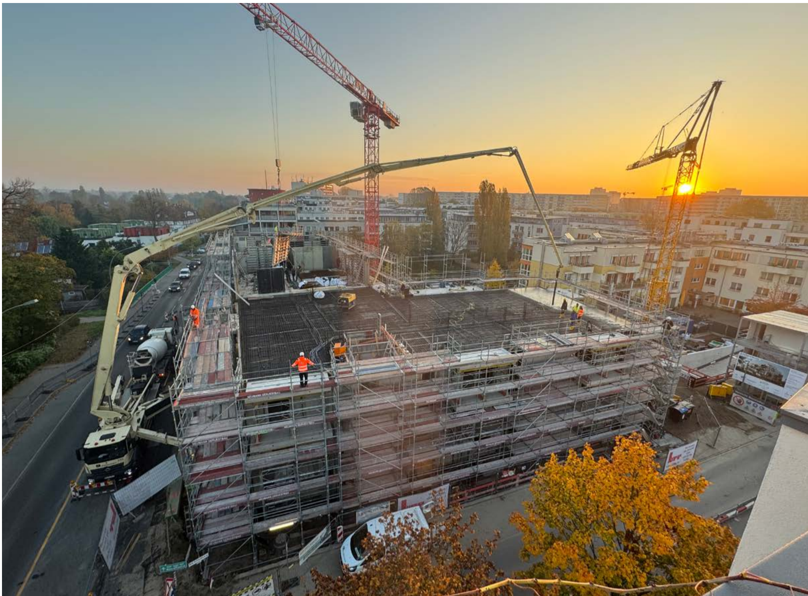
Während die Sonne gerade über Berlin-Köpenick aufgeht, ist die Betonpumpe mit extra langem Greifarm bereits im Einsatz. Ungeachtet der vielen logistischen Herausforderungen wächst der Rohbau des Schloßberg-Quartiers rasch in die Höhe.
