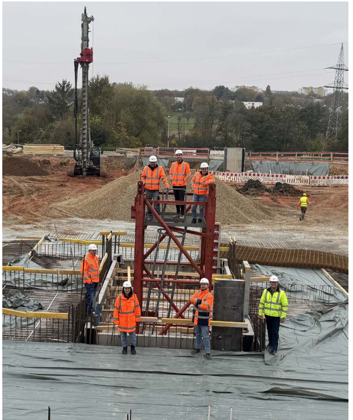
Baugrundverbesserung, Kranfundament und Infrastrukturarbeiten: Auf der Baustelle von FRA03 laufen derzeit viele Arbeiten parallel, dass zur Strategie des hoch motivierten Baustellenteams gehört. Es hat sich zum Ziel gesetzt, die Bauabläufe so zu optimieren, dass der Endtermin trotz des verzögerten Baustarts gehalten werden kann.
