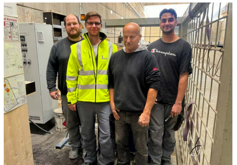
Nach der erfolgreichen Inbetriebnahme der elektrotechnischen Installationen für die PI-Platten-Schalung sind Alexander Feth, Carsten Lierow, Michael Jung und Noel Kröll (v. li. n. re.) zurecht stolz auf die geleistete Arbeit.
