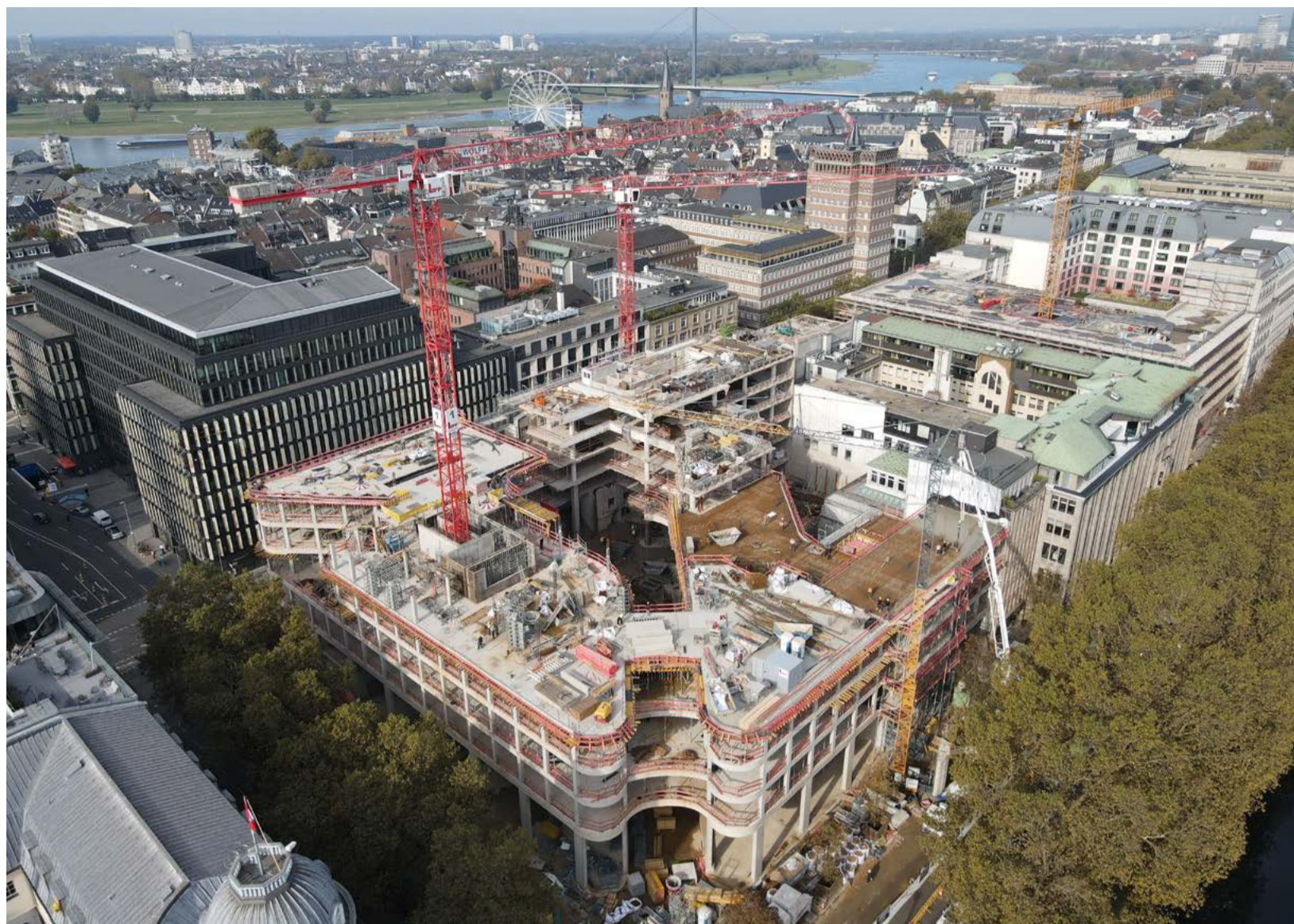
Neubau, Bestandssanierung mit Abbruch- und Rohbaumaßnahmen und das alles mitten in der Stadt. Obgleich das Projekt LE COEUR anspruchsvoll ist, nimmt das neue Herzstück Düsseldorfs beindruckend schnell Gestalt an.
