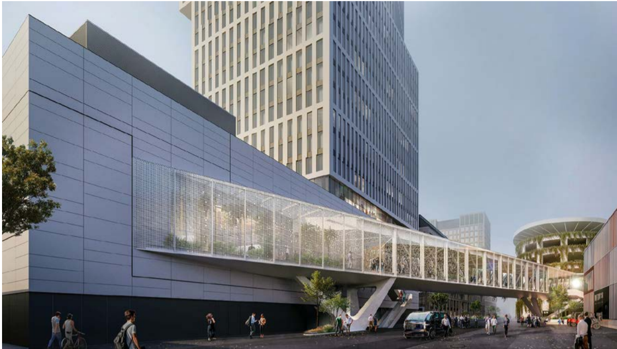
Der neue Abschnitt der Via Mobile schafft die kürzeste Verbindung zwischen dem Eingang Messeplatz und der Halle 12. Insgesamt wird die verglaste Brückenkonstruktion 105 Meter lang sein, 8,30 Meter breit und 6,90 Meter hoch.
