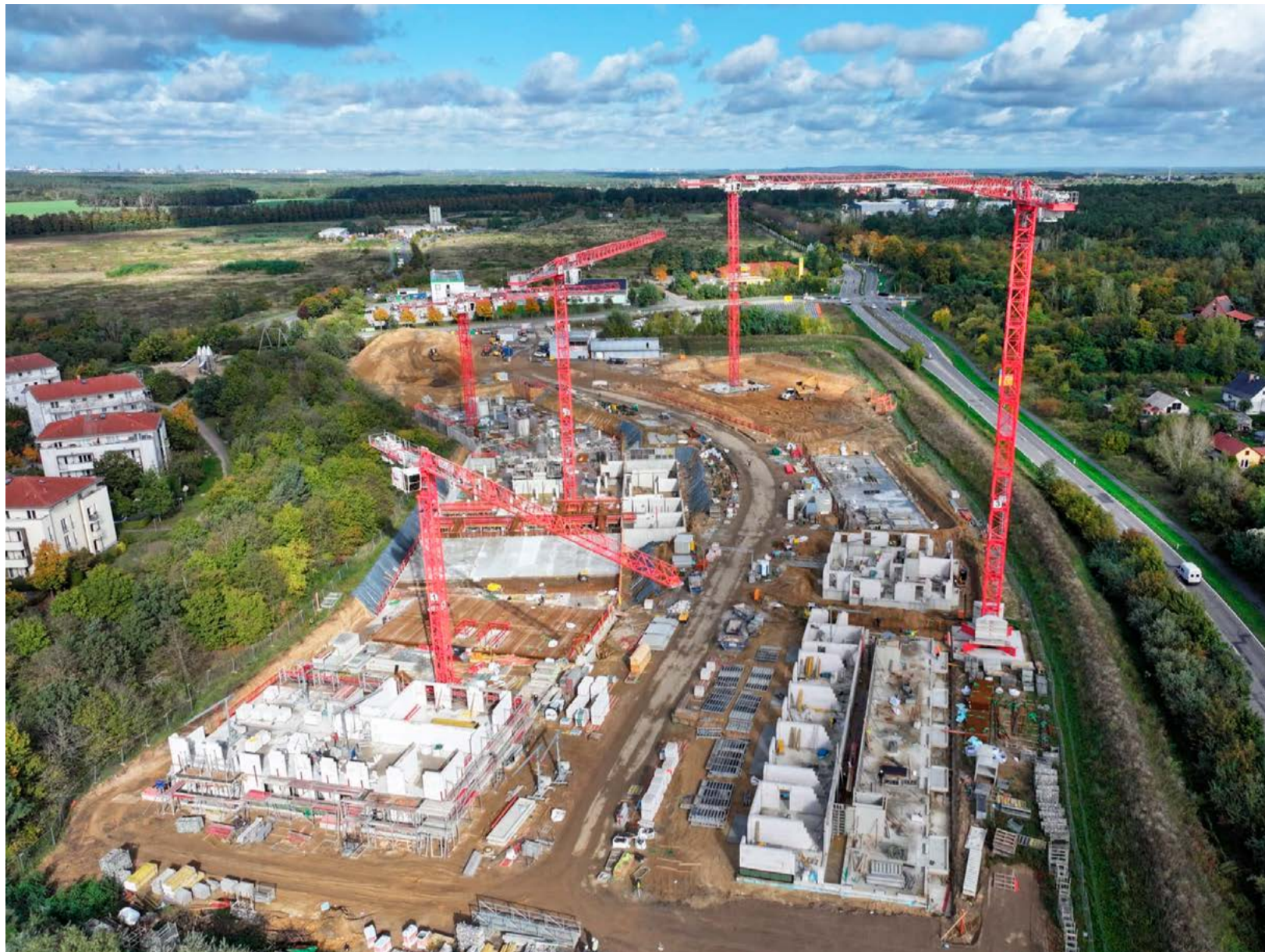
Mitten im Grünen und dennoch verkehrsgünstig zur Metropole Berlin gelegen, entsteht am Darwinbogen bis zum Frühjahr 2026 ein attraktives Wohnquartier mit 13 Mehrfamilienhäusern und zwei Tiefgaragen.
