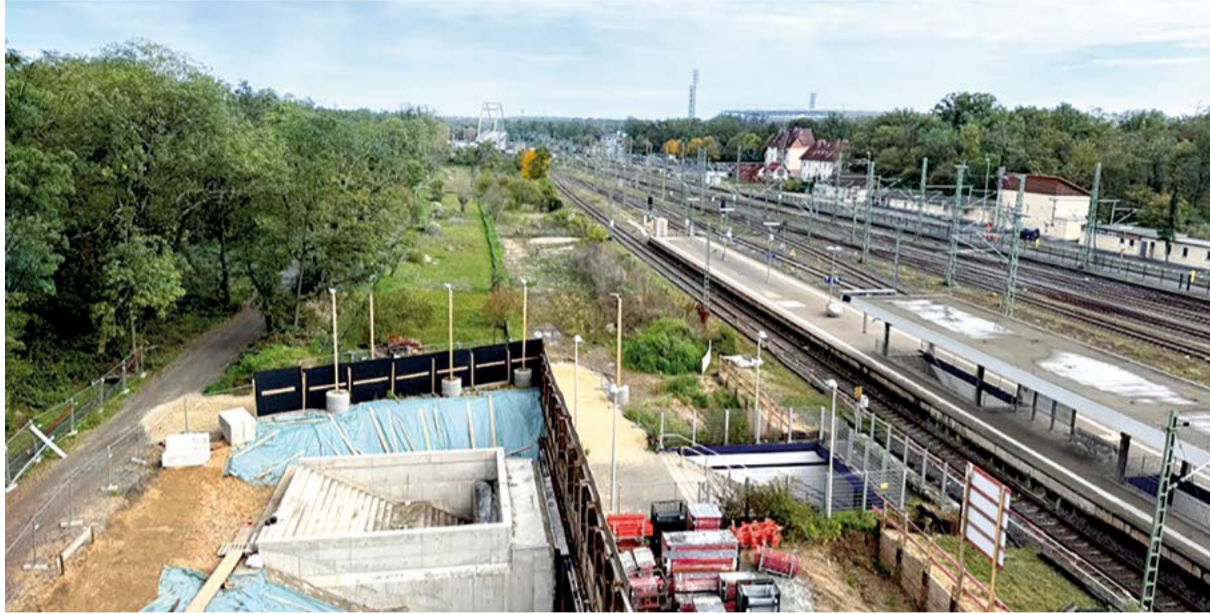
Frankfurt: Am Bahnhof Stadion entsteht die neue Personenunterführung Ost.
