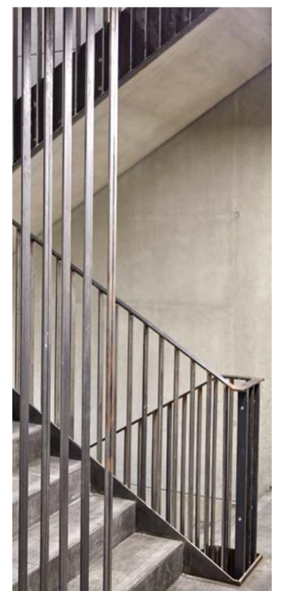
Bei dem in der Schlosserei angefertigten Treppengeländer aus Stahl wurde auf eine Pulverbeschichtung bewusst verzichtet.
