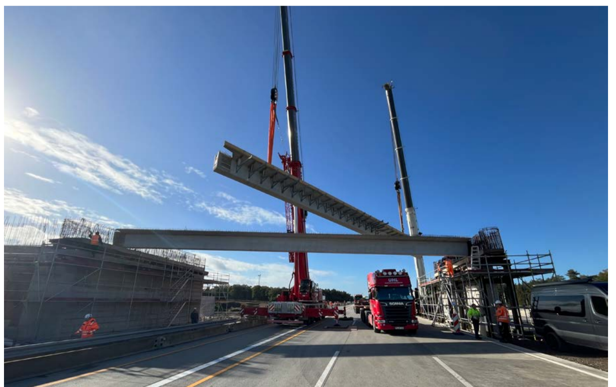
Die Brückenteile wurden mithilfe zweier großer Autokrane in Position gebracht. Bei diesem sogenannten Tandemhub müssen die Krane synchron arbeiten, um die massiven Bauteile millimetergenau auf das vorbereitete Traggerüst abzusetzen.
