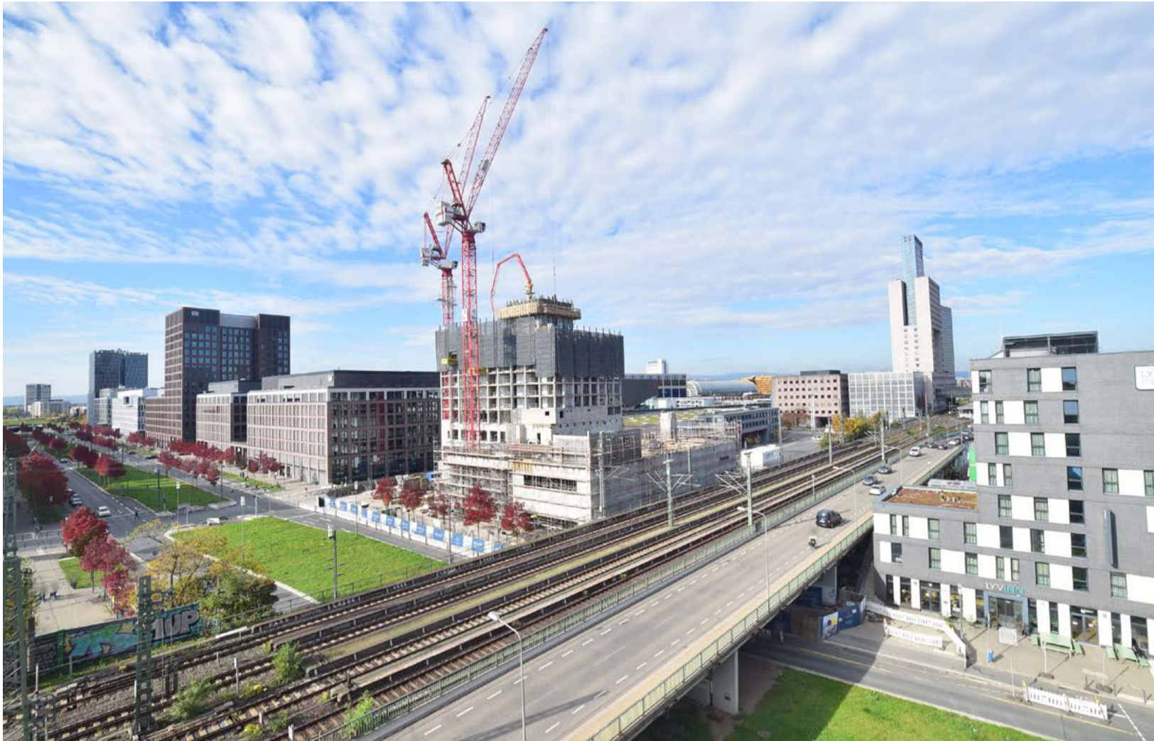
Der Europa-Allee-Tower wächst jede Woche um ein Geschoss. Dafür wird ein Teil des Hochhauskerns mittels Kranklettern zwei bis drei Geschosse vorausgebaut und der zweite Teil in konventioneller Bauweise mit der Decke nachgezogen.
