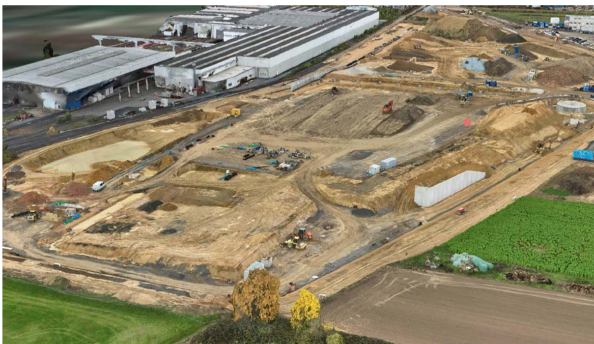
Wo derzeit noch zahlreiche Bagger fahren, sollen schon bald in einer achtgleisigen Wartungshalle die Züge der HLB gewartet werden. In der Werkstatthalle sind unter anderem mehrere 200 Meter lange Krananlagen, Dacharbeitsbühnen sowie ein Drehgestellkeller untergebracht.
