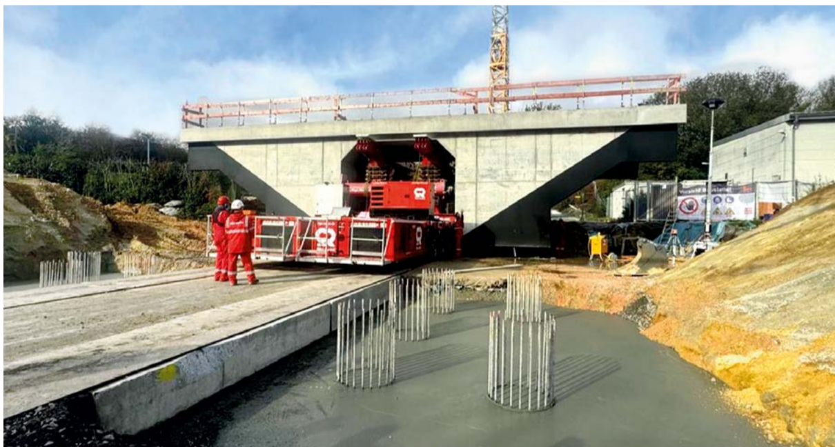
Friedberg: Das Einfahren der Brücke erfolgte mittels SPMT.
