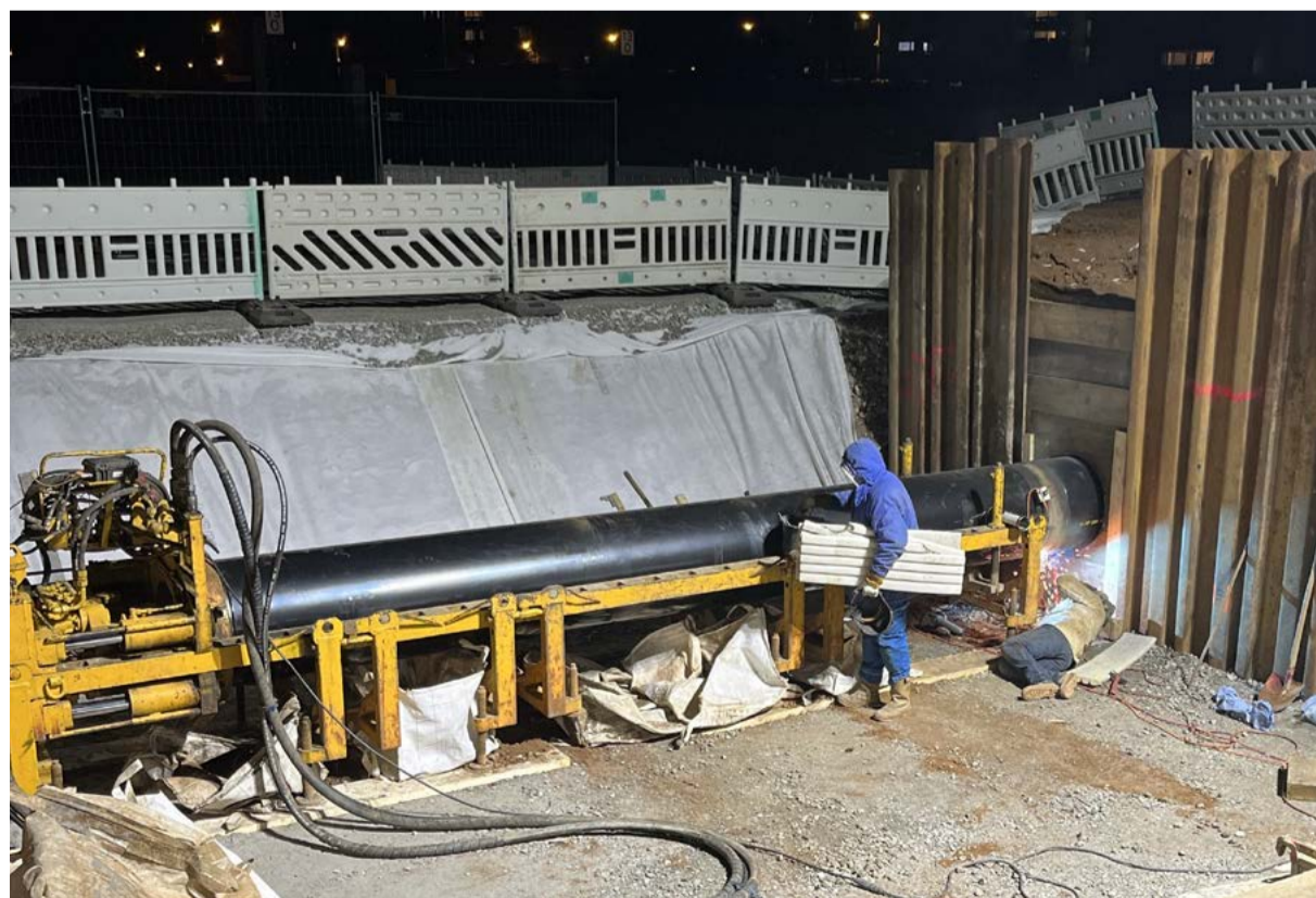
Das Verschweißen der Rohre in der Pressgrube erforderte nicht nur vollen Körpereinsatz, sondern auch höchste Präzision. Erst nachdem jede Naht per Röntgentechnik überprüft und mit PE und GFK umhüllt worden war, konnte der nächste Pressvorgang starten.
