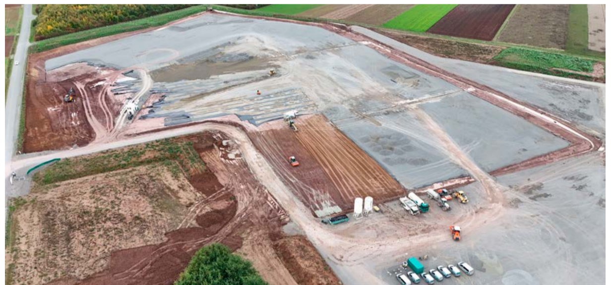
Bevor die Konverterstation im bayerischen Bergheimfeld errichtet werden kann, müssen umfangreiche Erdarbeiten durchgeführt werden. Das ca. 67.000 Quadratmeter große Areal erhält zum Abschluss eine Schottertragschicht als stabile Grundlage.
