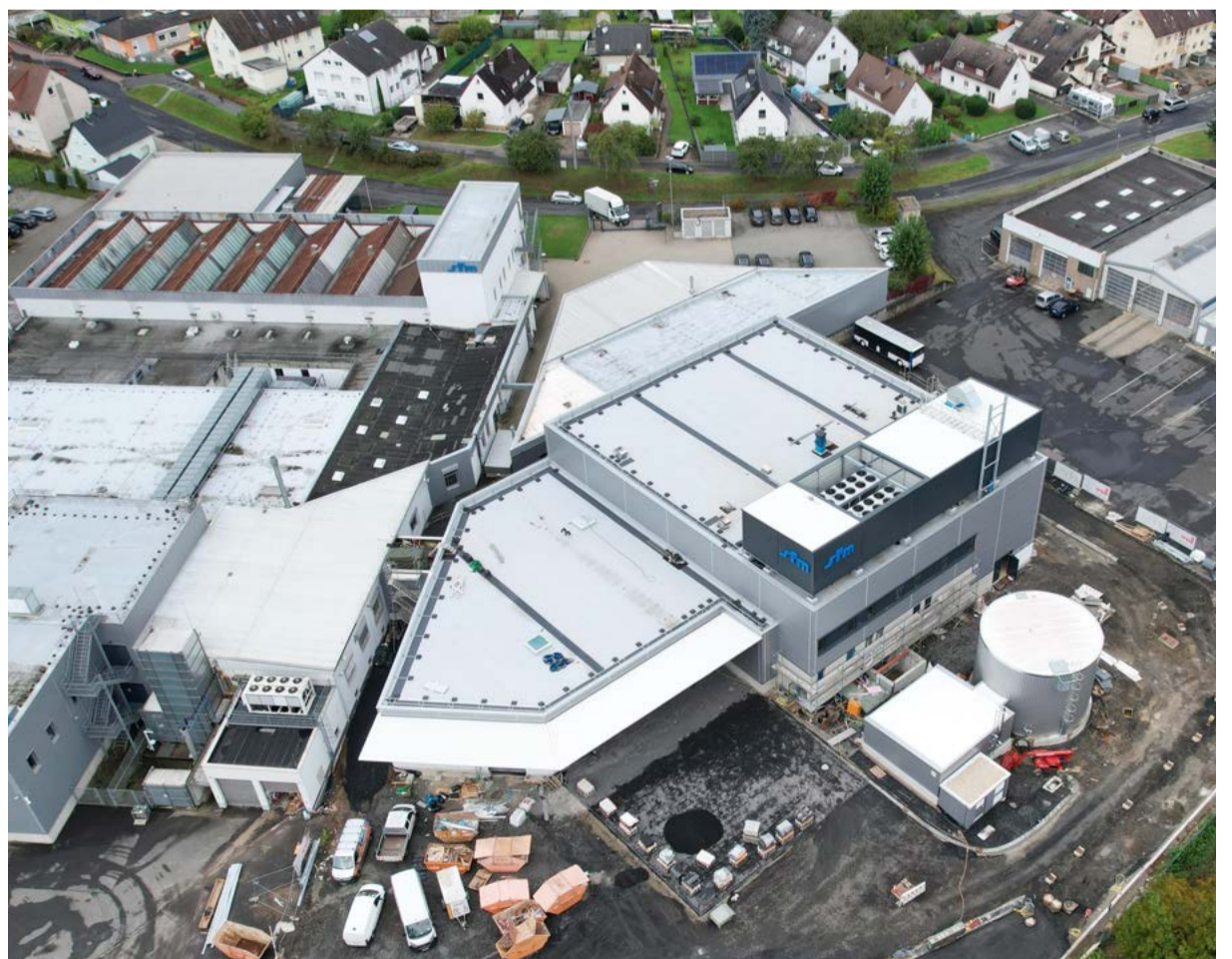
Die Drohnenaufnahme zeigt das neue Werk 2 neben dem bestehenden Werk 1. Die Dach- und Fassadenarbeiten des Neubaus sind abgeschlossen und auch die Nebenanlagen Sprinklerzentrale und -tank wurden bereits fertiggestellt. Parallel zum laufenden Innenausbau durch Lupp werden die Haustechnik-, Pflaster- und Asphaltarbeiten durchgeführt.
